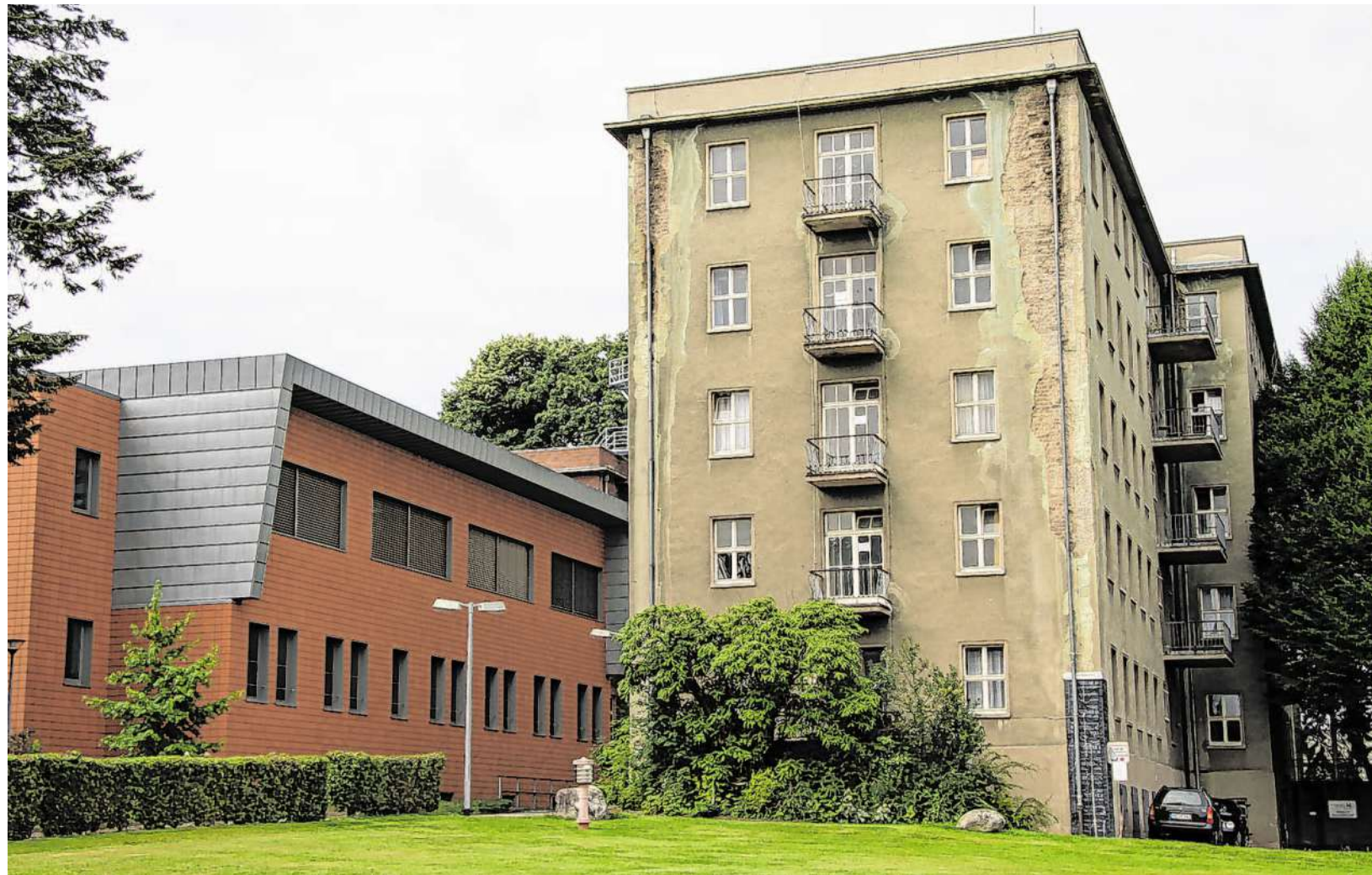
Alt und neu nebeneinander: Bald Geschichte ist das ausgediente Schwesternheim auf dem Gelände des ehemaligen Knappschaftskrankenhauses in Bardenberg (r.). Das marode Gebäude soll abgerissen werden, um dort die Schule für Krankenpflegeberufe zu errichten. Dagegen wird der noch recht neue OP-Trakt anders genutzt. Das Aachener Schwertbad will dort eine Frührehabilitation für neurologische Patienten einrichten. Foto: Karl Stüber
