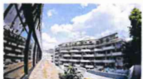
► 35 Wohnungen zwischen 70 und 300 Quadratmetern Größe: Der Neubau neben dem Landesbad ist in vollem Gange. Was mit der Schwimmballe (links im Bild) geschieht, ist noch offen.
